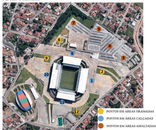
Figura 2 - Posição dos 12 pontos de coletas no Complexo da Arena Pantanal
