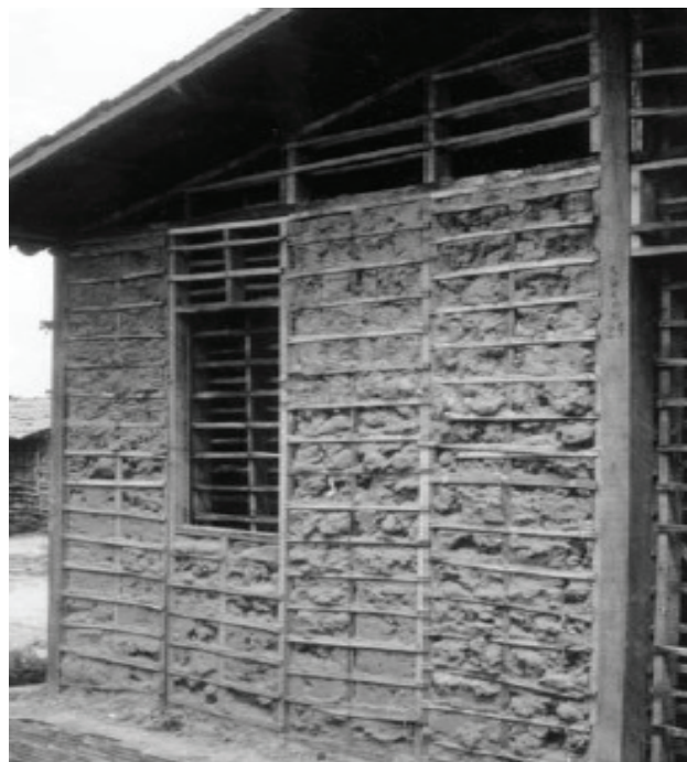
Figura 17. Casa moldada com painéis de pau-a-pique com solo
