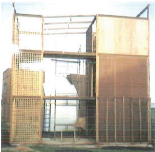
Figura 16 - Dois modelos de formas para a compactação da estrutura monolítica. Taipal tradicional (à esquerda) e taipal metálico
