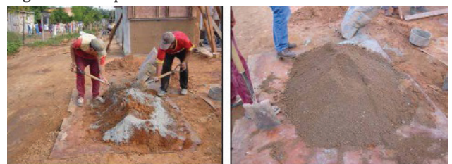
Figura 12 - Preparo da mistura solo-cimento
