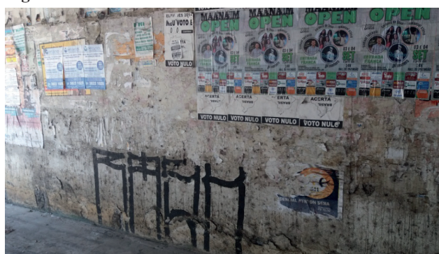
Figura 4 - Passarela subterrânea Usiminas.
